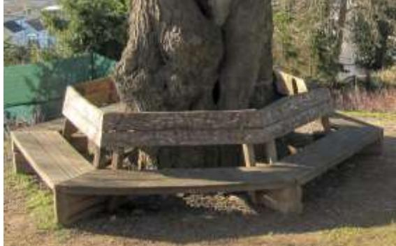
Als Sonderform der Holzblockbauweise könnte die Bank an der Lutherlinde gelten, die rund um den Stamm auf Holzblöcken aufgebaut wurde. Leider sind die Rundhölzer direkt auf den Boden gelegt.
